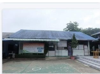
อาคารเอนกประสงค์ (สร้างเอง) อายุการใช้งาน ๓๗ ปี
