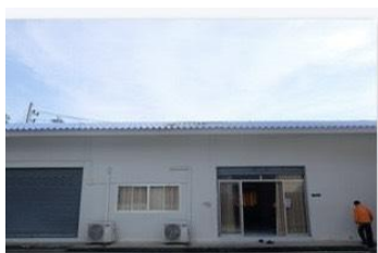
อาคารเอนกประสงค์ (สร้างเอง) อายุการใช้งาน ๑๑ ปี
