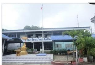
อาคารเรียน สปช.๑๐๑/๒๖ ขนาด ๓ ห้องเรียน ๑ ห้องธุรการ อายุการใช้งาน ๓๙ ปี
