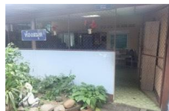
อาคารเอนกประสงค์ (สร้างเอง) อายุการใช้งาน ๓๐ ปี
