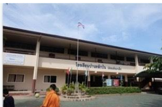
อาคารเรียน สปช.๑๐๑/๒๙ ปรับปรุง ๒ ชั้น ๔ ห้องเรียน (ชั้นล่างโล่ง) อายุการใช้งาน ๑๑ ปี
