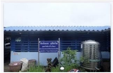
ห้องน้ำ ห้องส้วม อายุการใช้งาน ๑๓ ปี
