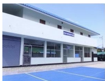
อาคารเอนกประสงค์ (สร้างเอง) อายุการใช้งาน ๑๑ ปี
