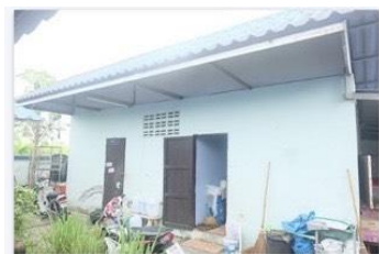
บ้านพักภารโรง อายุการใช้งาน ๑๓ ปี
