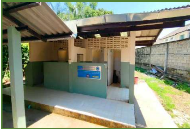
ห้องน้ำนักเรียนชาย (งบบริจาค)
